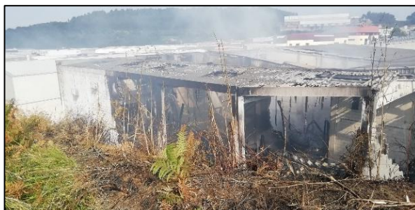
Situación final de la parcela R 10 el día después del incendio.
